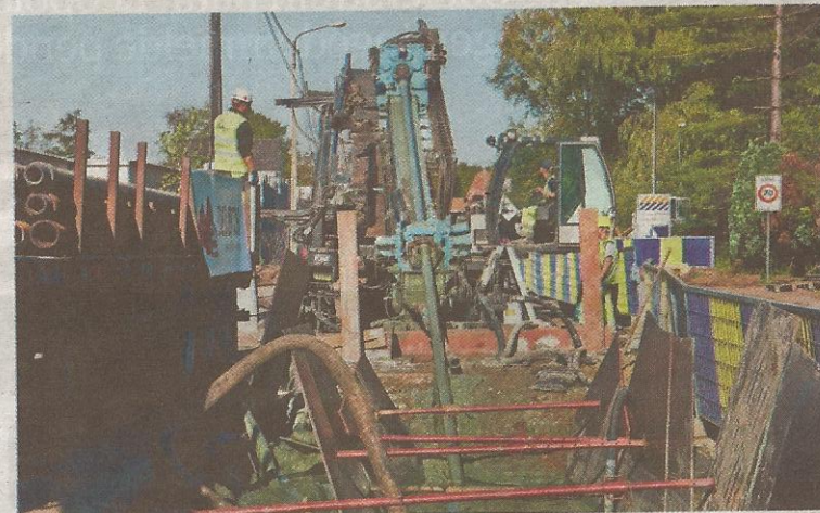
Met een grote machine worden de gietijzeren pijpen onder het Albertkanaal doorgetrokken. FOTO BERT DE DEKEN
